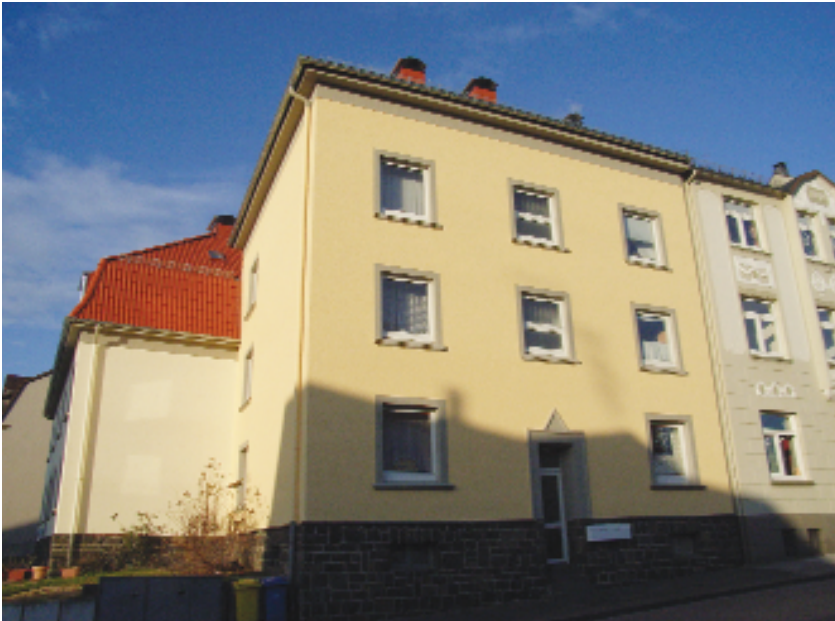
Dach- und Fassadensanierung Locher Straße 60
