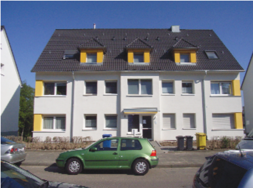
Dach- und Fassadensanierung Grimmstraße 8
