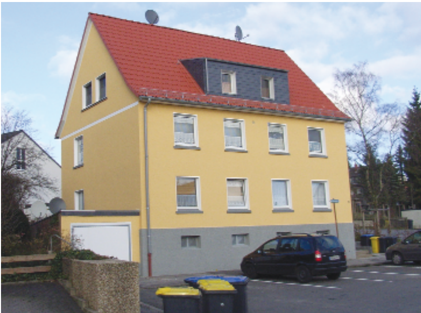
Dach- und Fassadensanierung Schlegelstraße 15
