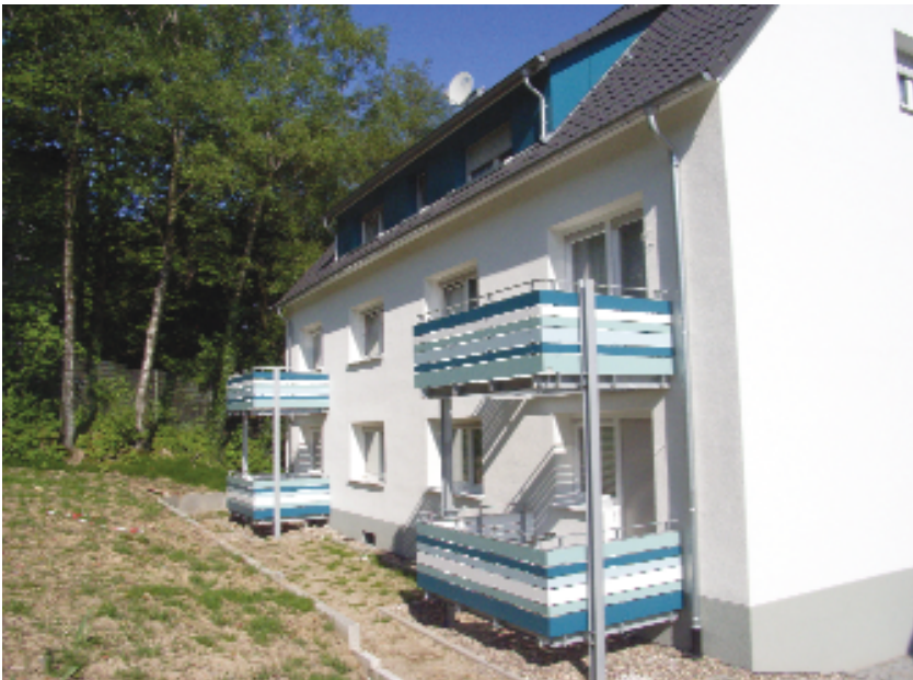
Balkonanbau Lehner Straße 39
