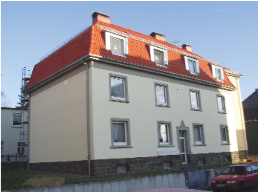
Dach- und Fassadensanierung Heidstraße 31
