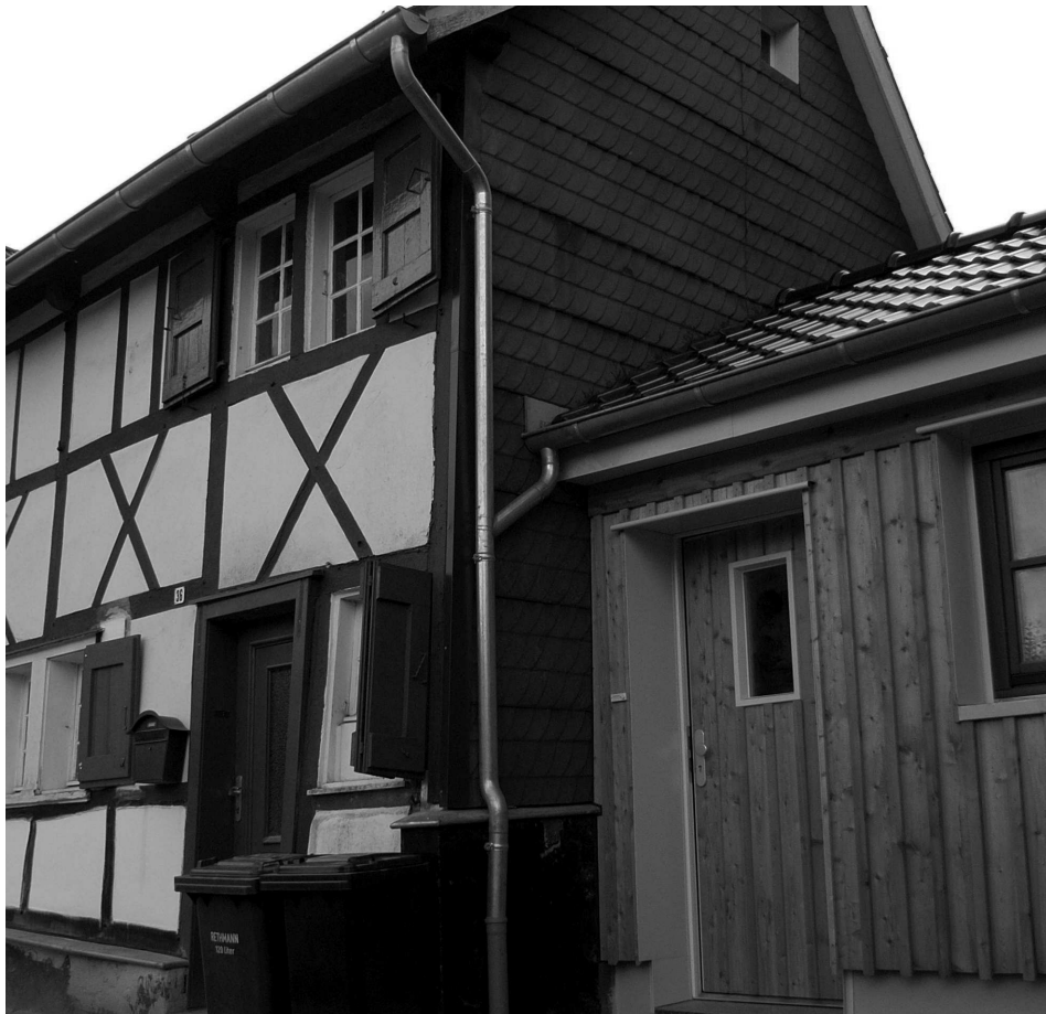
Fachwerkhaus Krausen 36 nach der Sanierung
