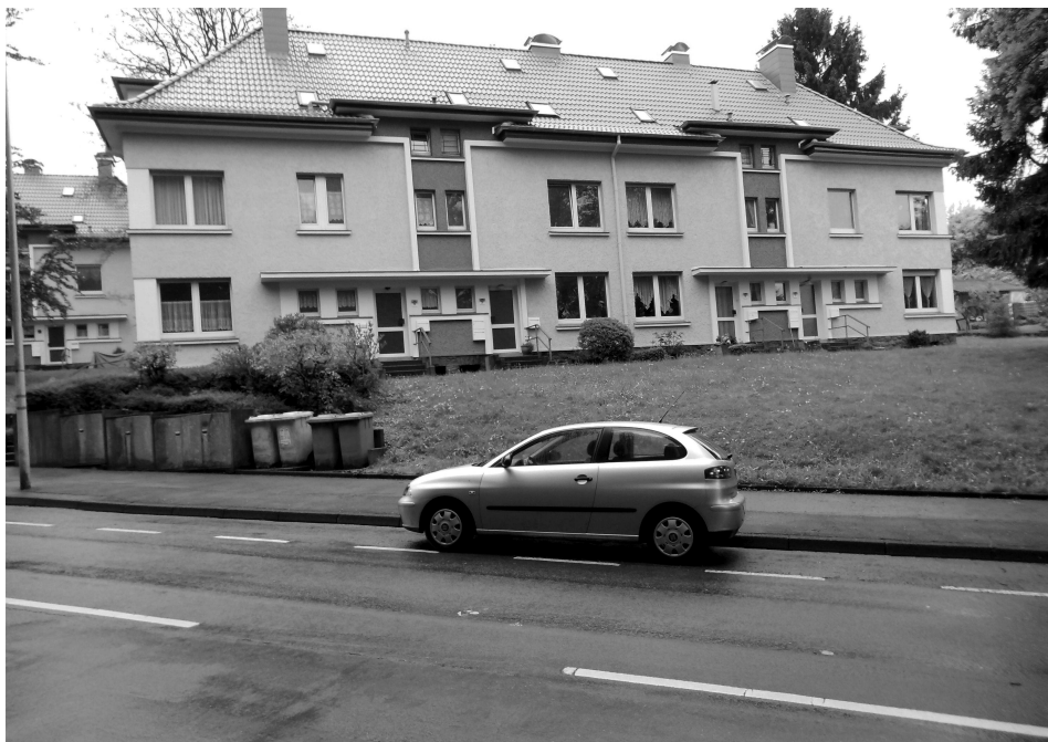
Zeppelinstr. 26-32 nach der Sanierung
